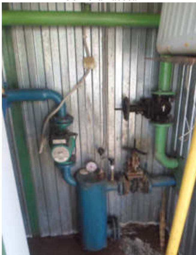
Видимое изображение №2 Обвязка насоса
