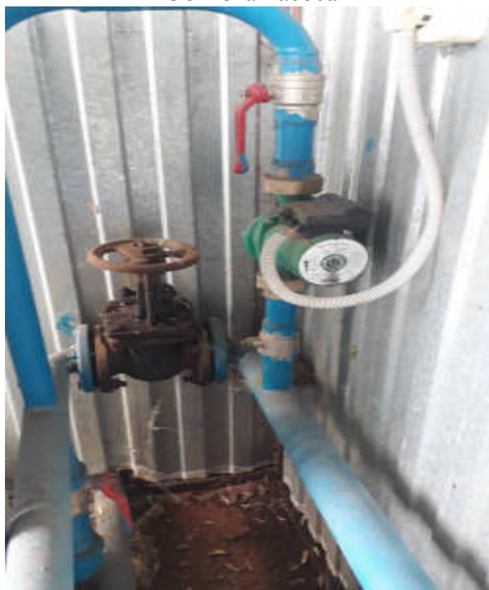
Видимое изображение №2 Обвязка насоса
