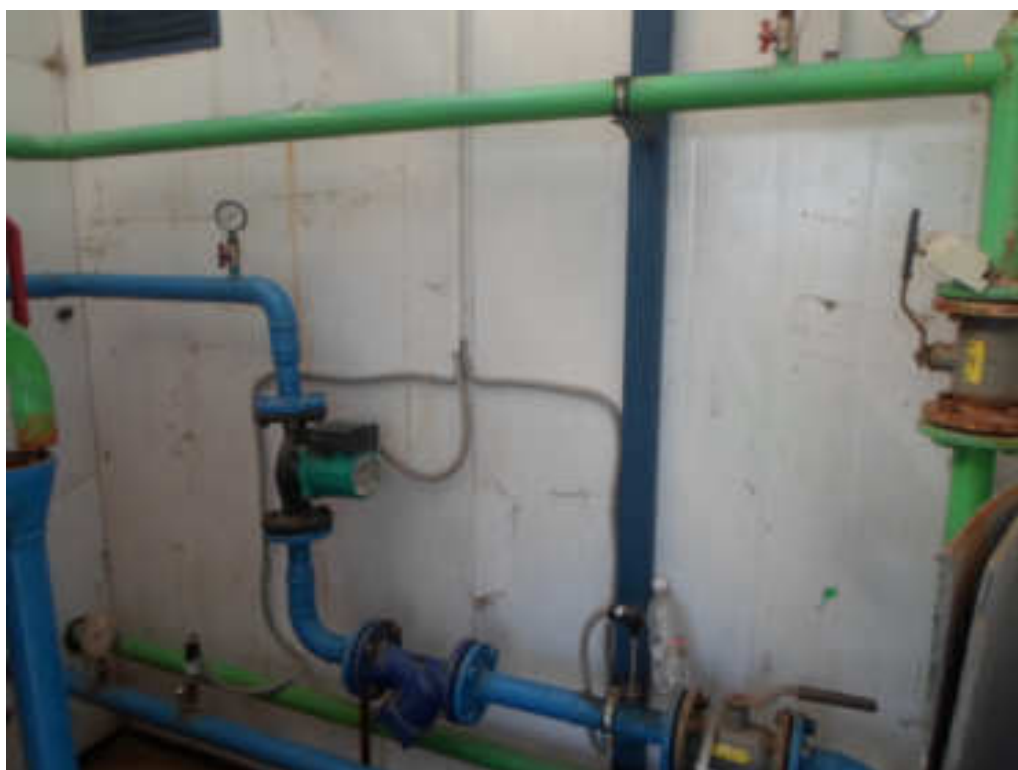
Видимое изображение №2 Обвязка насоса
